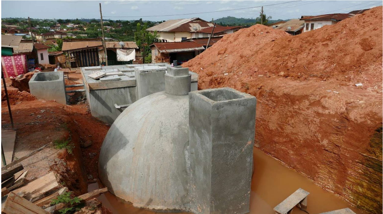
[Abbildung 2: Bauphase der Biogas-Sanitäranlage –
