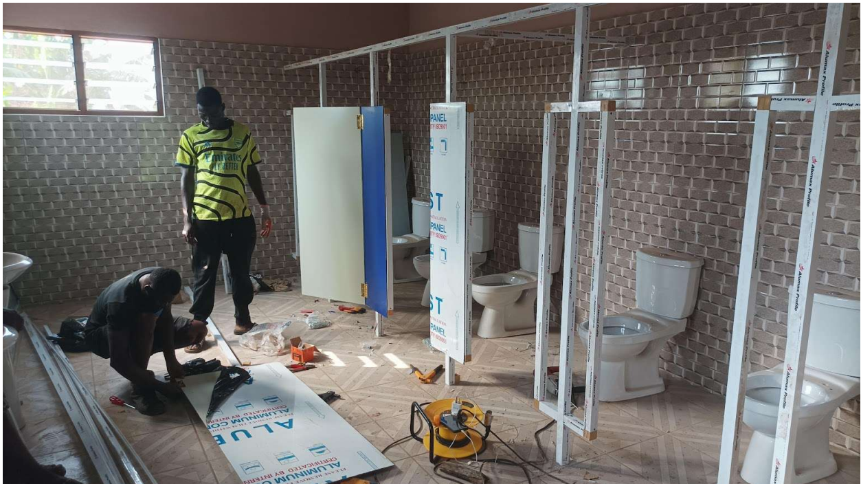
[Abbildung 3: Innenansicht der fertiggestellten Sanitäranlagen mit installierten Toiletteneinheiten]
